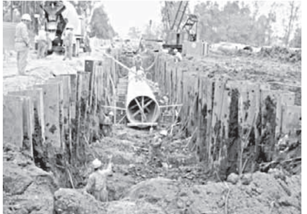
Trabajadores de la empresa de Acueducto y Alcantarillado de Bogotá.
