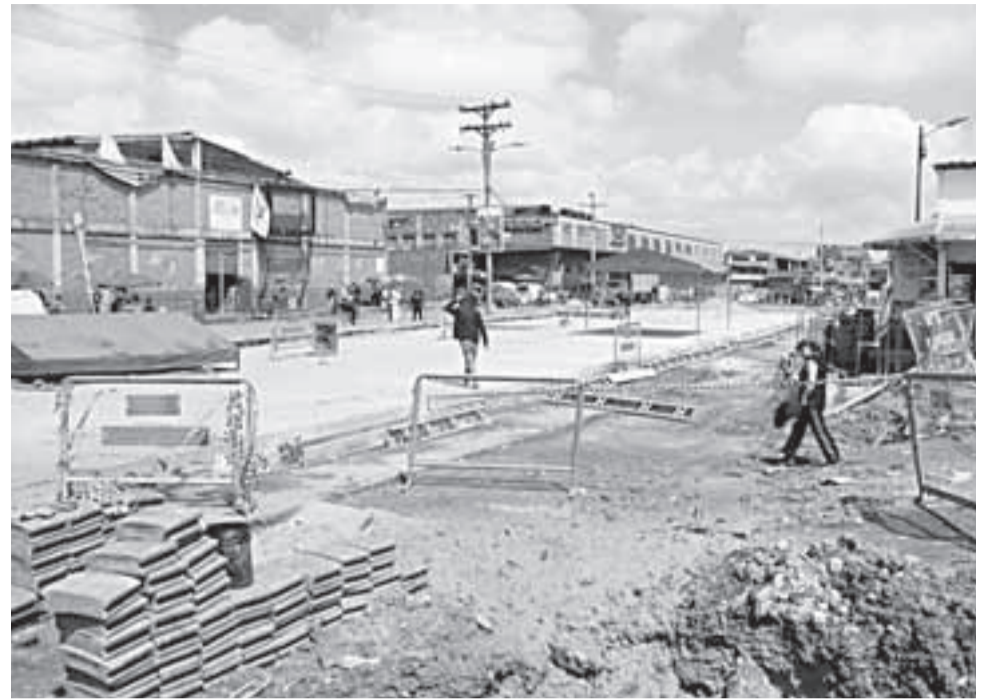
Existe un contrato desde 2004 para adecuación vial, por un valor de 342 mil millones de pesos. Foto Redacción Bogotá.
